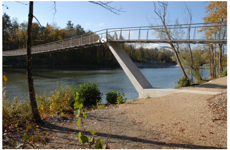
Die neue Spannbandbrücke über die Aare bei Rapperswil gehört zu den flankierenden Massnahmen, mit denen die Akzeptanz der Flussrenaturierung bei der Bevölkerung erhöht wurde.
