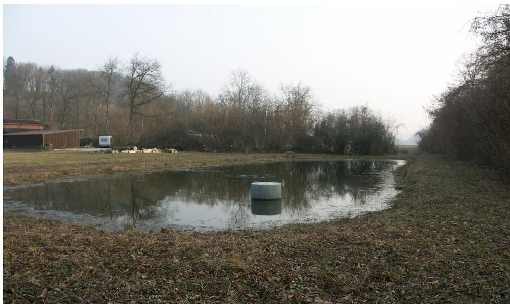
In der Laupenau BE hat die karch einen Folienweiher mit einem künstlichen Ablass erstellt (im Betonschacht verborgen). Oben der Weiher in trockenem, unten in gefülltem Zustand.
