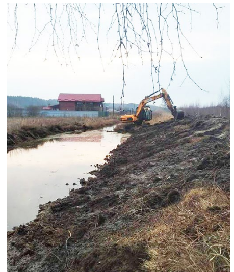
Notwendige Arbeiten im Feuchtgebiet «Wolf Hill» in der Ukraine. © USPB
